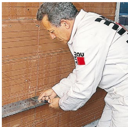
Профилът на цокъл с дебелината на плочите се закрепва с дюбели и се запелва например с лепило на Baumit KantenFix.
