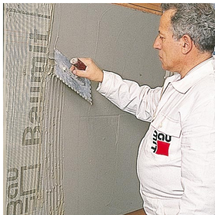
След прешлифване на плочите: нанася се лепилото и се влага мрежа от стъклотекстил (припокриване най-малко 10 cm).
