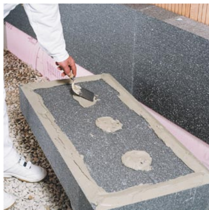
Лепилото се нанася върху плочата Austrotherm EPS® F-PLUS по контура на плочата и точково по цялата повърхност.
