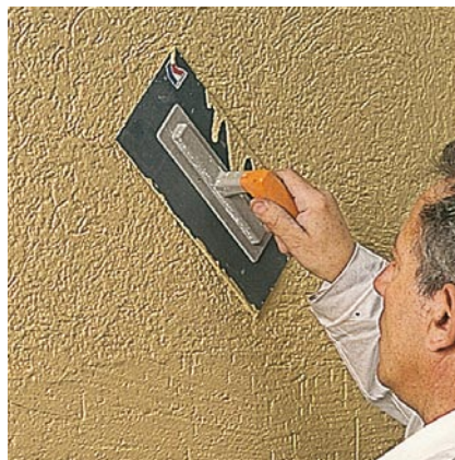
Тънкослойна мазилка (напр. Baumit SilikonPutz, Baumit SilikatPutz) се нанася и се структурира.
