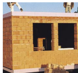
Оставащият кофраж Austrotherm XPS®/TOP® предотвратява образуването на термостове в областта на плочата
